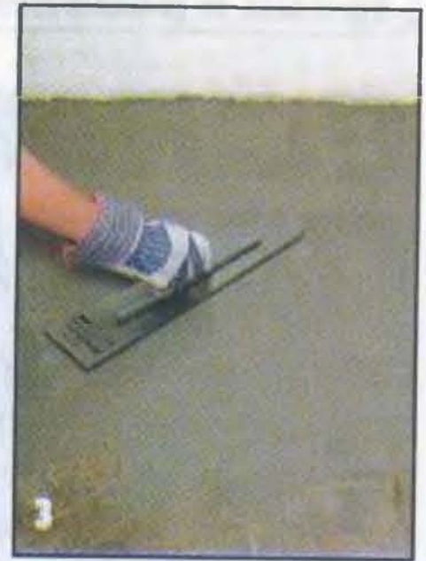
Терка — идеальный инструмент для предварительного разравнивания раствора.
