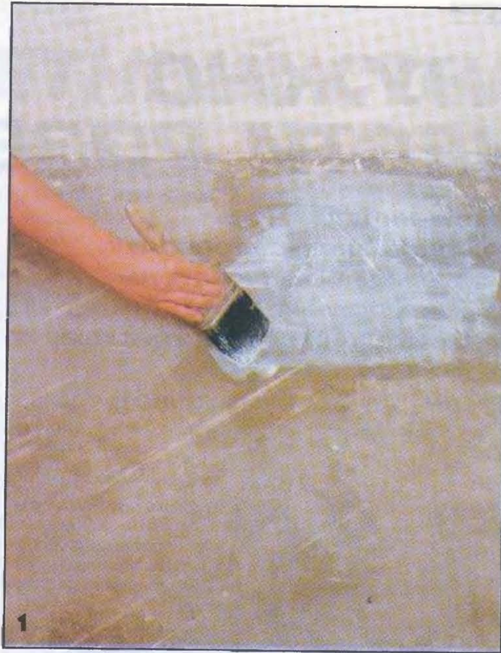
До нанесения выравнивающего раствора весь пол грунтуют разбавленным клеем ПВА.
