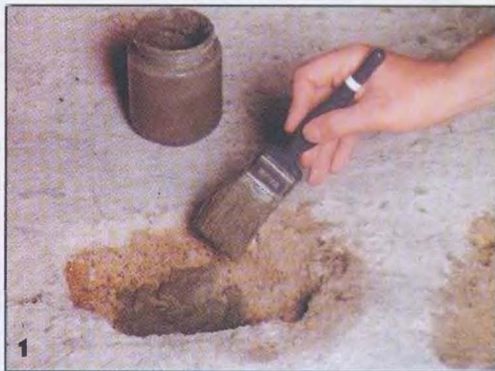
Сначала выбоину грунтуют разбавленным клеем ПВА.
