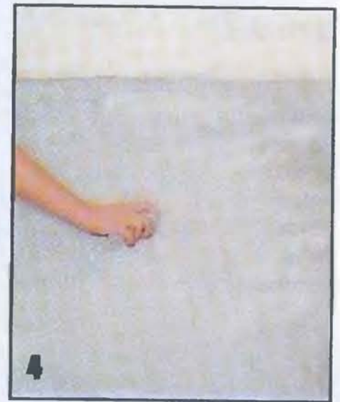
Поверхность самовыравнивающегося раствора разгладится сама, но мелкие неровности придется зачистить.
